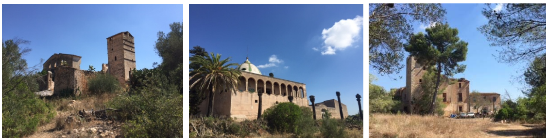
Imatges de masies en ruïna o parcialment enderrocades
